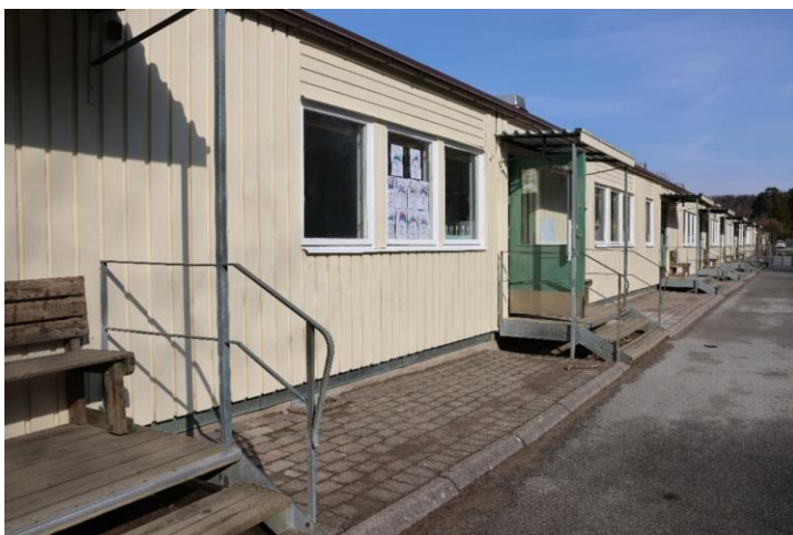
Mellan entrétrapporna fanns ursprungligen rabatter. Ytan är numera stenlagd.
