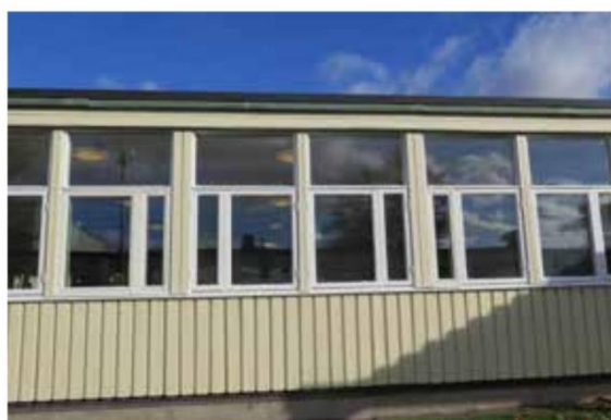
Skolans vita träfönster och takfot i ärgad koppar.
