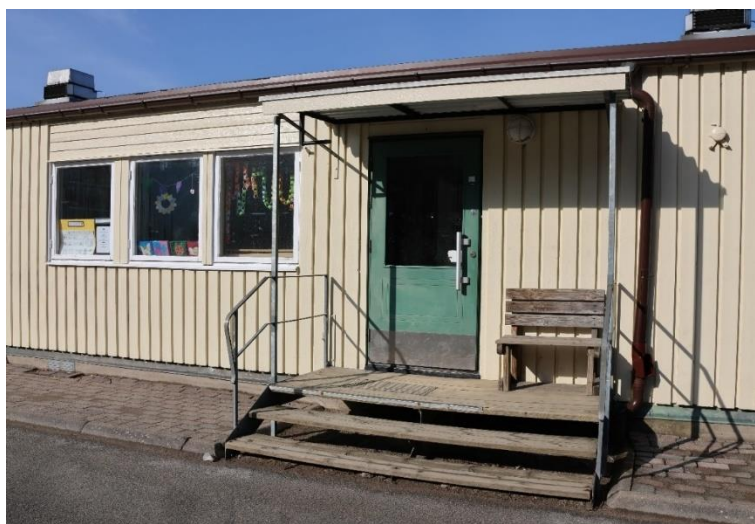
Fönsterband och entré mot rastgård, i huvudsak i originalutförande. Fönsterblecket samt takfotsavtäckningens plåt är utbytta.
