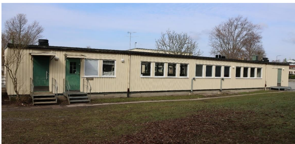
Fasad mot öster har en mer anonym karaktär med sidoentréer och fönsterband med låga fönster. Markytan utanför är icke-aktivitetsbaserad.
