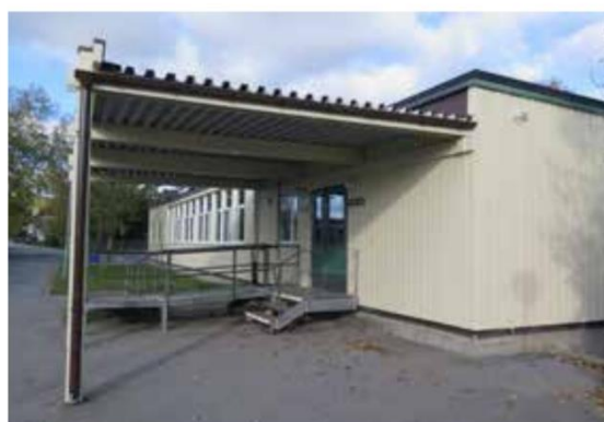
Matsalsbyggnadens skärmtakskyddade entré.
