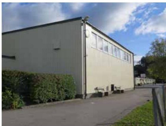
Gymnastikbyggnadens halldel reser sig tydligt över de övriga byggnaderna.
