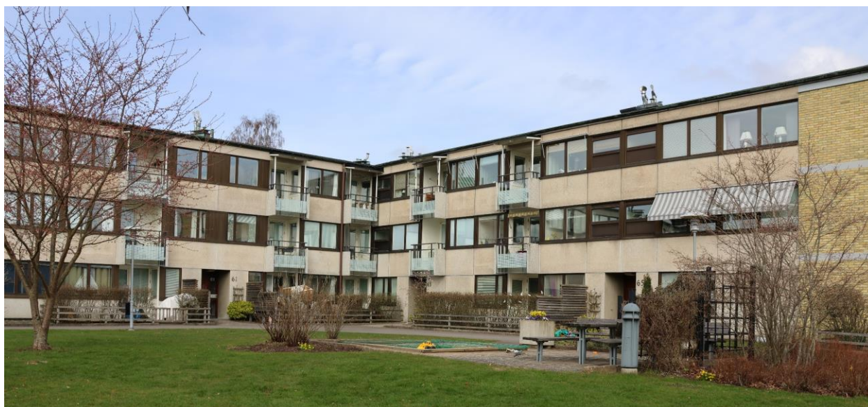
Öppen karaktär mot gårdarna med balkonger och fönsterband. Fasader i betong och träpanel. Utbytta balkongfronter.
