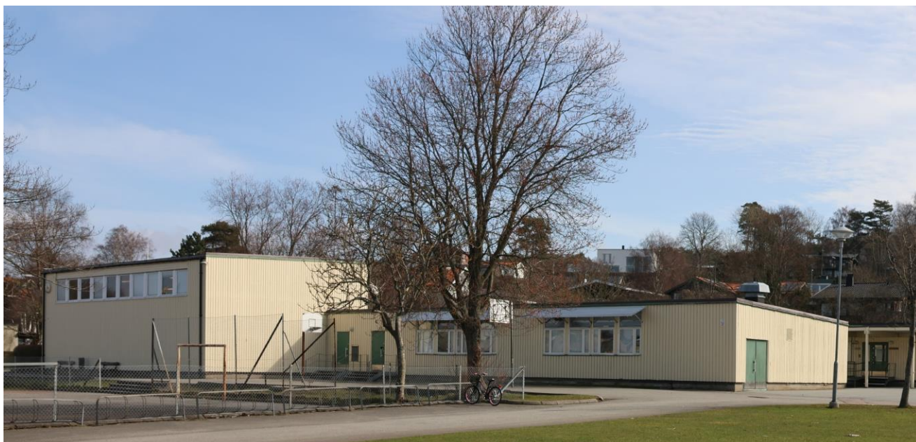
Idrotts- och slöjdbyggnad med högdal för gymnastiksal och med omklädningsrum och slöjdsalar i lågdelen. Vy från sydväst, med tillbyggnad till höger i bild. De höga fönsterbanden visar var slöjdsalarna ligger.
